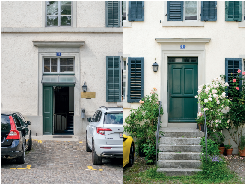
6 Left: Entrance front Escherhäuser
