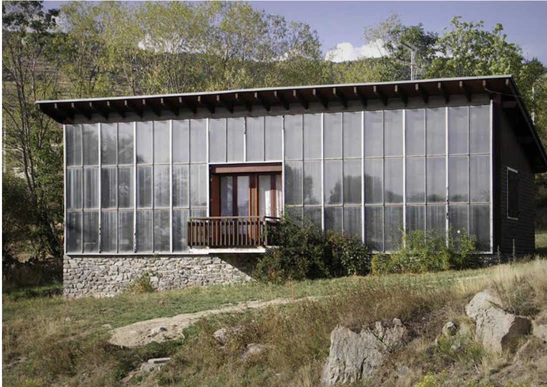
13 Die Südfassade des Trombe Hauses mit der Trombe Wall
