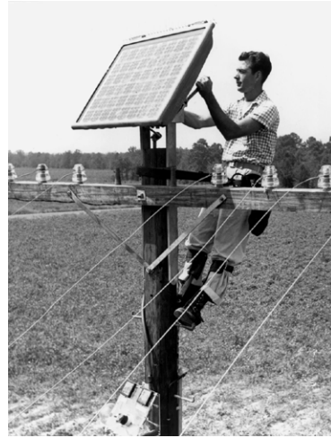
5 Montage einer Bell Solar Battery bei einem Telefonsystem speziell für ländliche Regionen.
